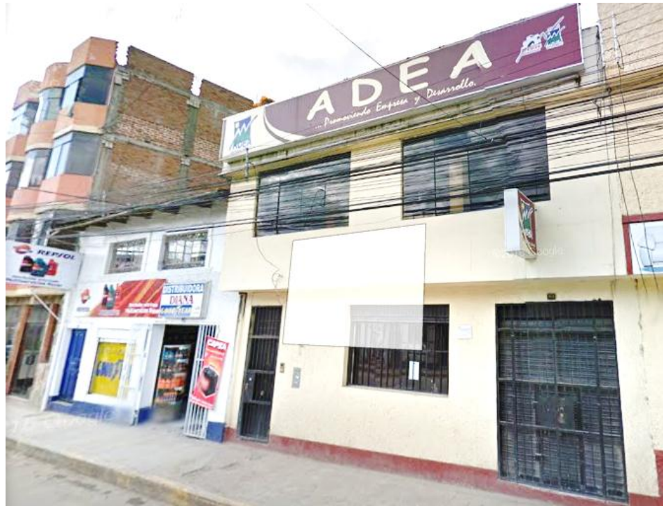
Figura 3: Fotografía de la fachada de la oficina Andahuaylas en 2014 Fuente: Google Maps
