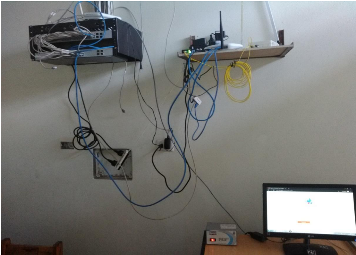
Foto5: Conexión del coordinador con el servidor web.
