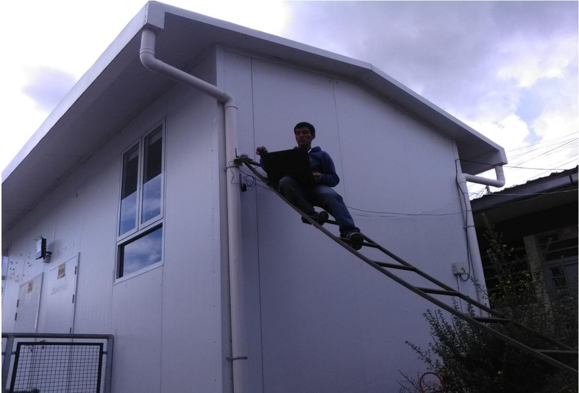
Foto4: Instalación del coordinador.
