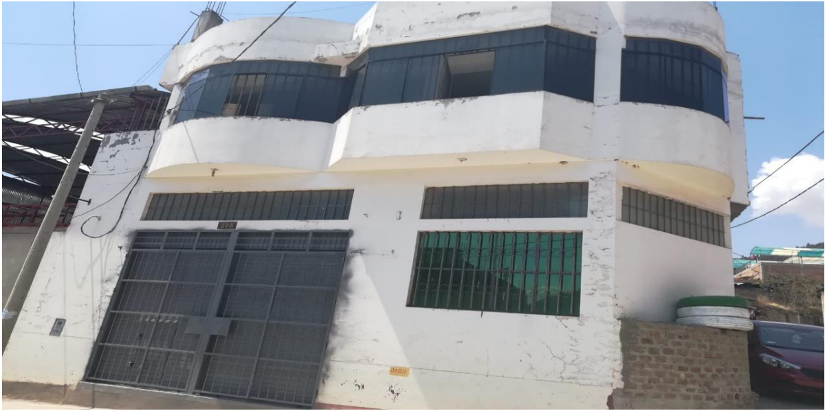
Almacén de la distribuidora CASTRO E.I.R.L.
