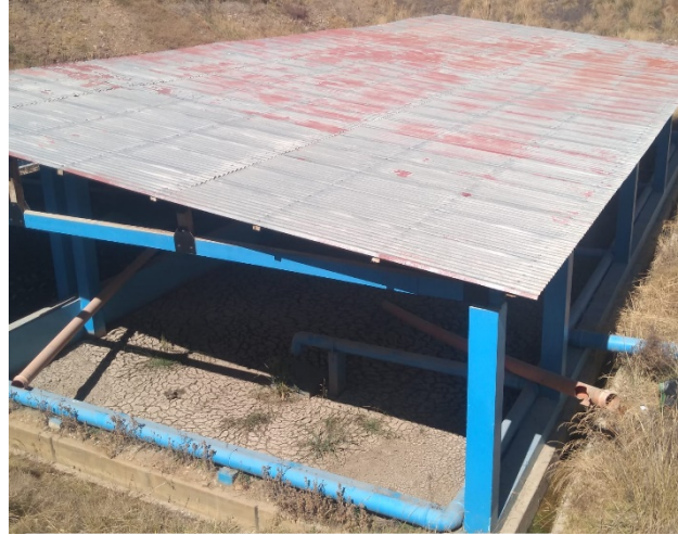
Fotografía 21: Lecho de secado de la PTAR
