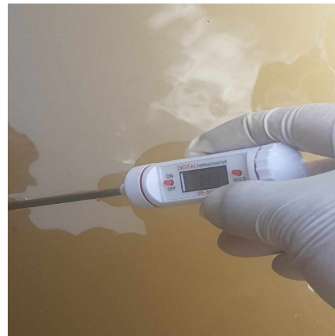
Fotografía 22: Medición de temperatura en el afluente de la PTAR
