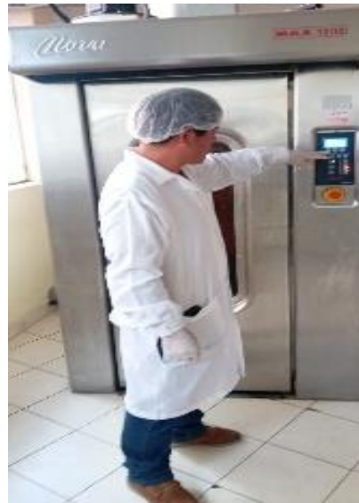
Foto 12: se programó e implementó el calentamiento de horno eléctrico.
